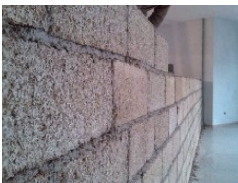
Internal partition of Blocco Ambiente ®
